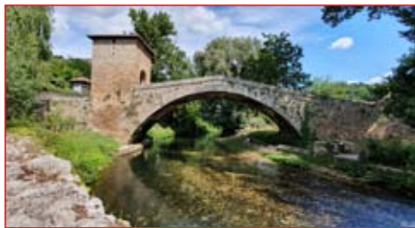
Ponte San Francesco, Fiume Aniene - Subiaco
