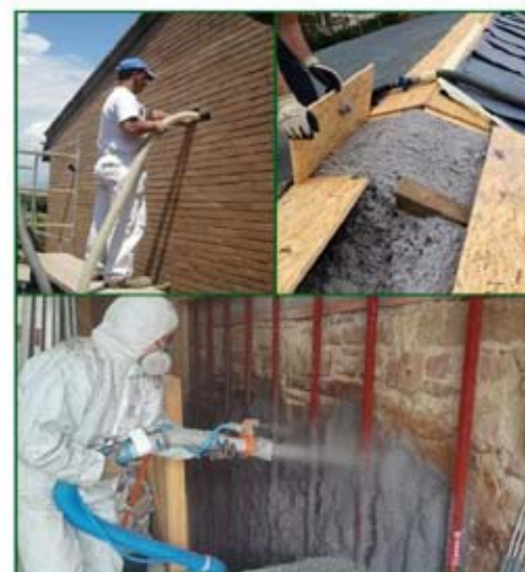
Isolamento termico con insufflaggio fibra di cellulosa
