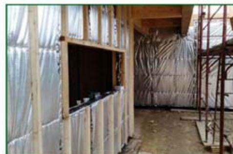
Isolamento termico a cappotto in multiriflettente
