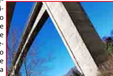
Parte del Ponte che necessita manutenzione
