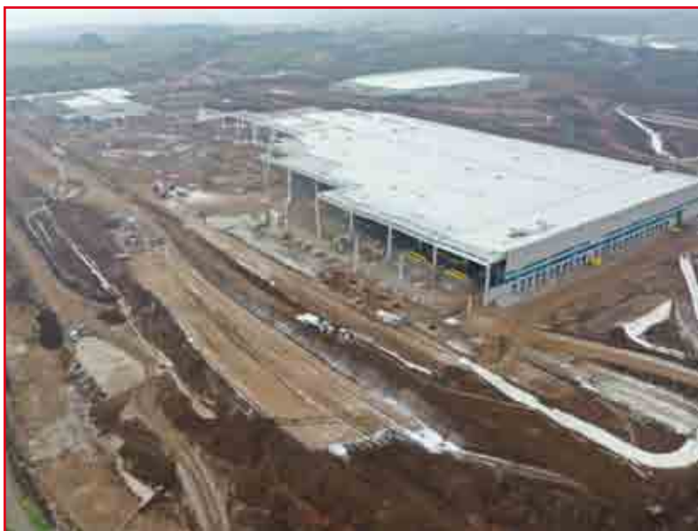
Veduta aerea della struttura AMAZON a Colleferro ancora in costruzione
