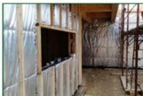
Isolamento termico a cappotto in multiriflettente
