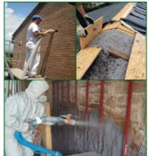
Isolamento termico con insufflaggio fibra di cellulosa
